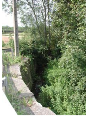
Le ru de Préfolle accompagné de végétations, au devant de la ferme de la Croix Blanche, vue depuis la RD619.
