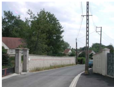
Constructions récentes et murs, rue du bois de Vitry
