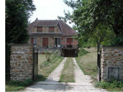
Exemple de constructions en bordure du bois de Vitry, Allée de Maurevert
